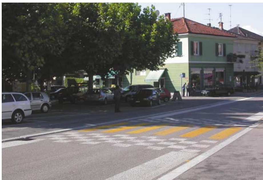
Immagine 6 – Segnalazione rampe di raccordo con pittura a due componenti strutturata di colore bianco (quadrotti a scacchiera 50x50 cm secondo VSS 640.851)
