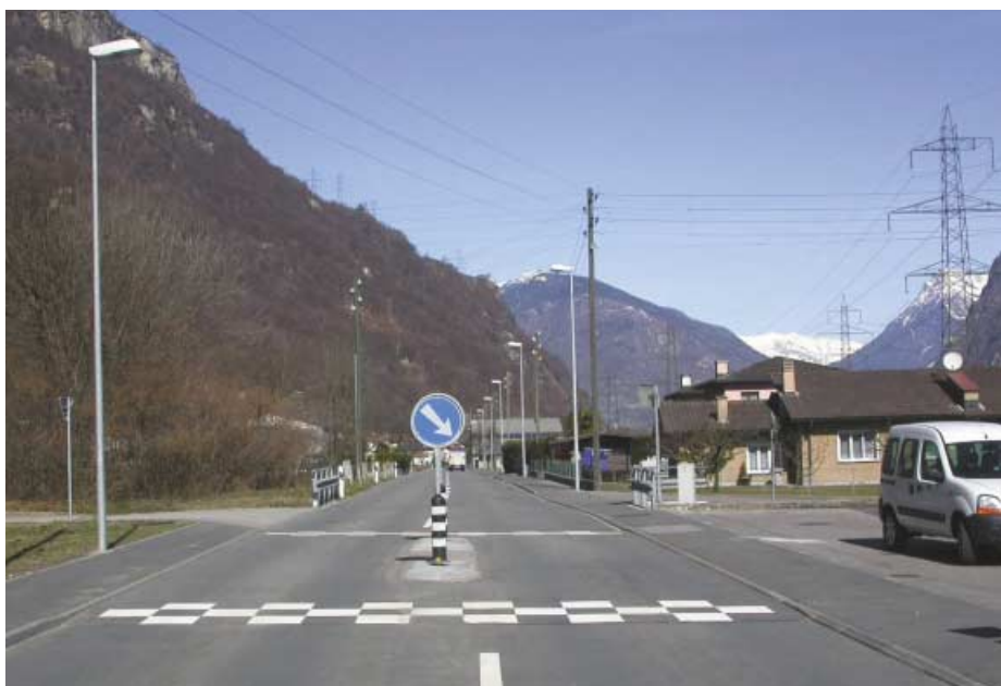
Immagine 12 – Segnalazione rampe di raccordo con pittura a due componenti strutturata di colore bianco (quadrotti a scacchiera 50x50 cm secondo VSS 640.851)
