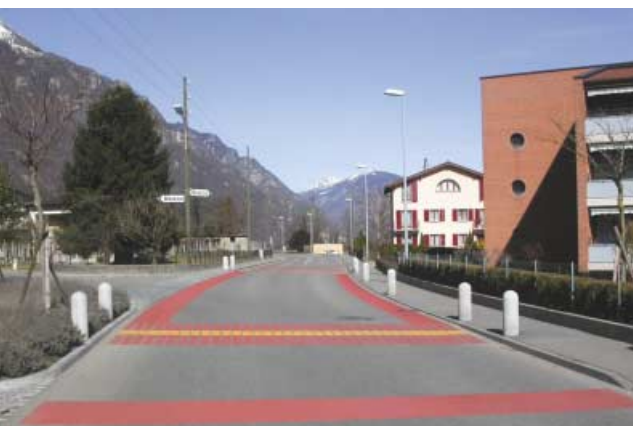
Immagine 10 – Elementi di arredo urbano e pavimentazione diversificata (il colore giallo non viene più accettato)
