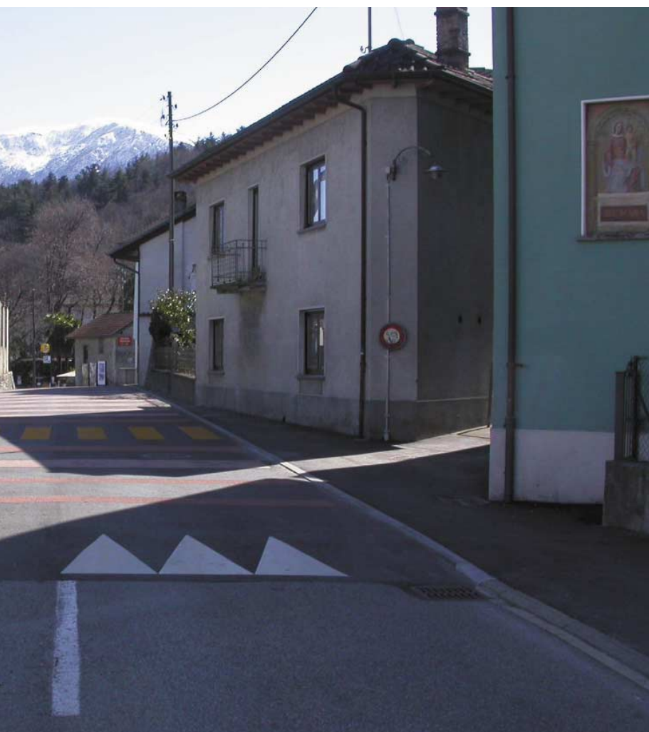
Immagine 13 – Segnalazione rampe di raccordo con pittura a due componenti strutturata di colore bianco (triangoli bianchi secondo VSS 640.851)
