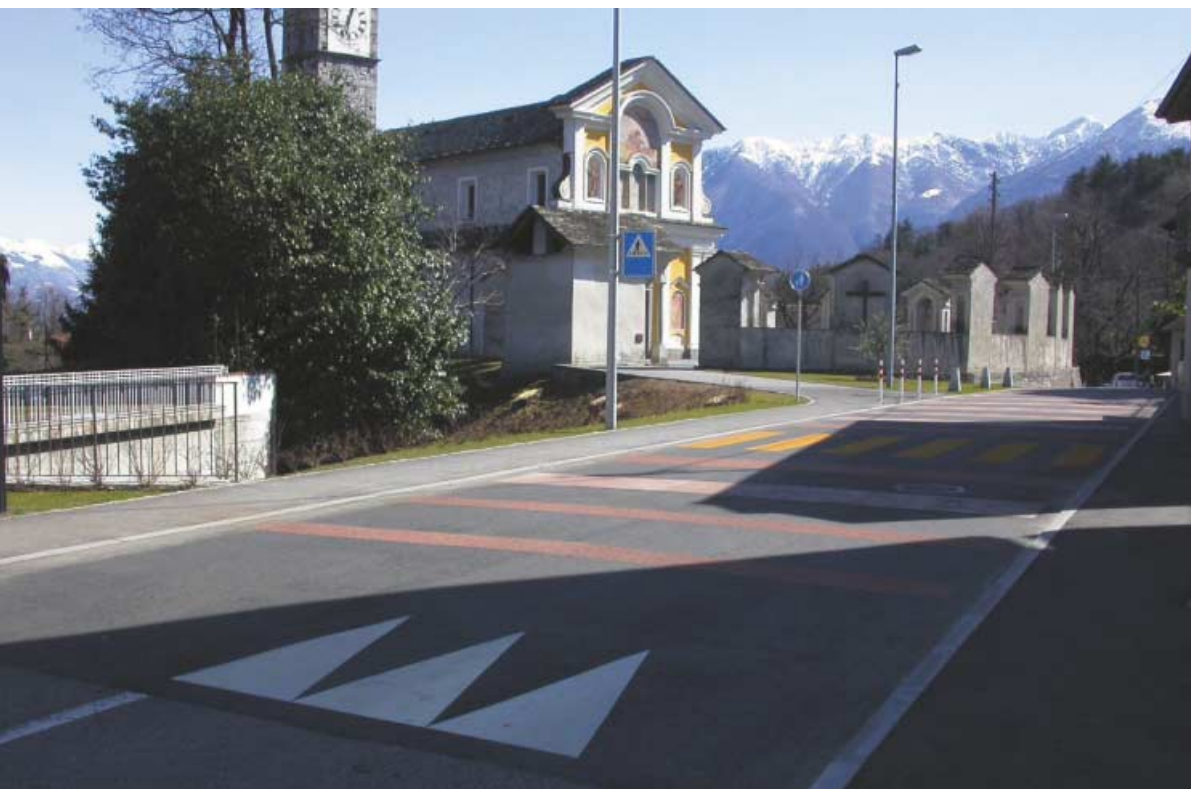
Immagine 7 – Segnalazione rampe di raccordo con pittura a due componenti strutturata di colore bianco (triangoli bianchi secondo VSS 640.851)
