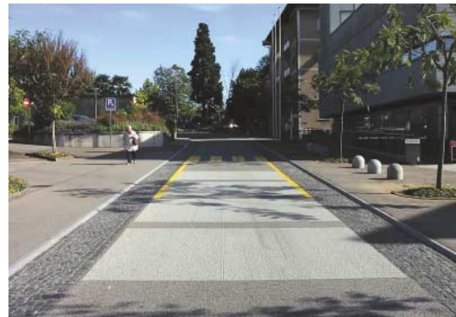
Immagine 3 – Pavimentazioni diversificate (strada a senso unico)
