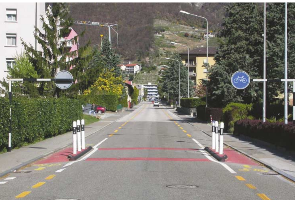
Immagine 8 – Restringimenti laterali mediante la posa di colonnine bianconero
