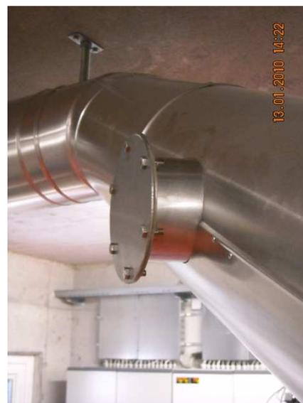
**Figura 1:** Flangia standardizzata EMPA per la misura delle emissioni
