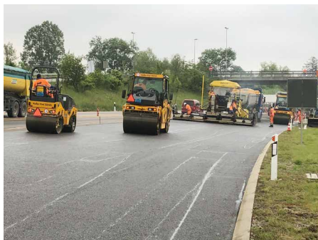
Messa in opera di miscele riciclate (Bülach-Kloten, Canton Zurigo).
