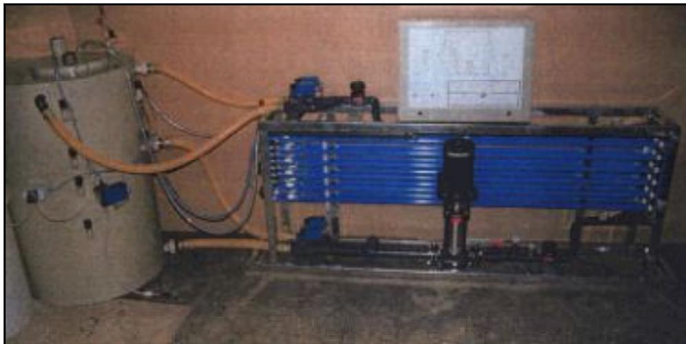
**Figura 23:** impianto ad ultrafiltrazione a membrane
