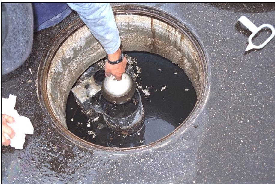
**figura 14:** dettaglio della chiusura di sicurezza di un separatore funzionante grazie alla diversa densità di acqua e idrocarburi
