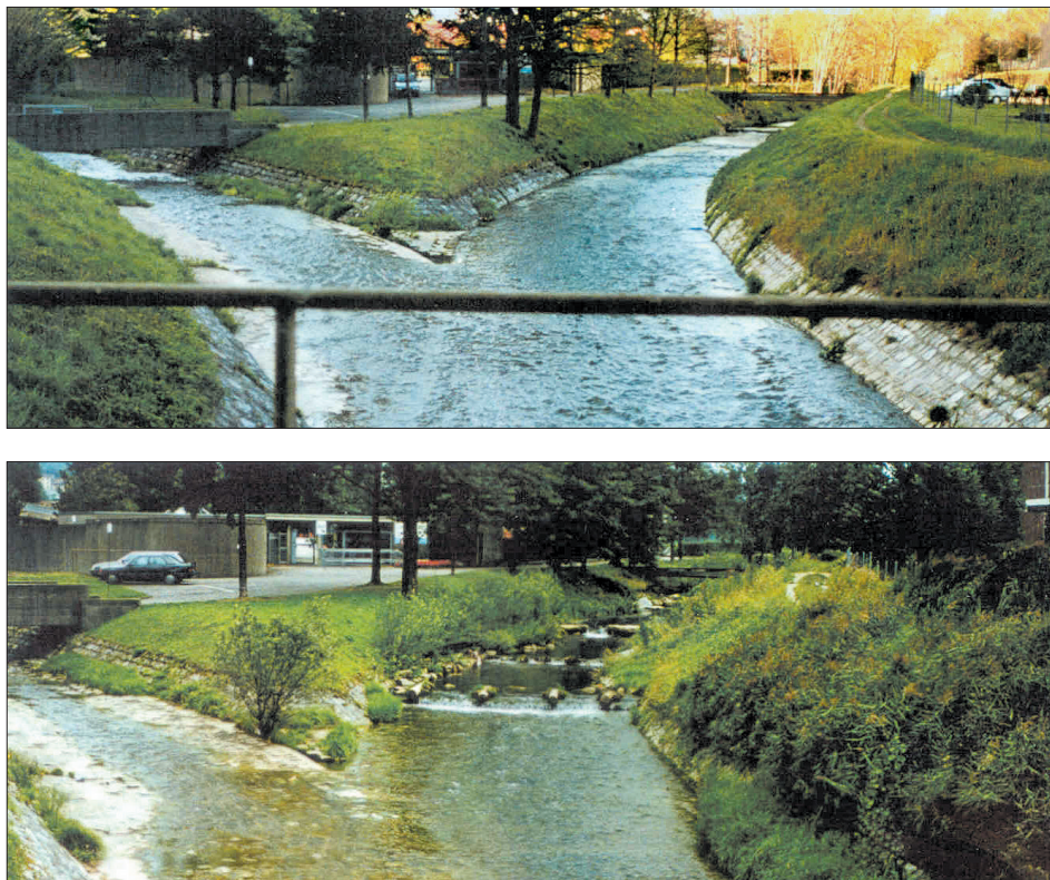
Tratto del Laveggio prima (sopra, nel 1994) e dopo l'intervento di rivitalizzazione (sotto, nel 1997) Figura 2.27
