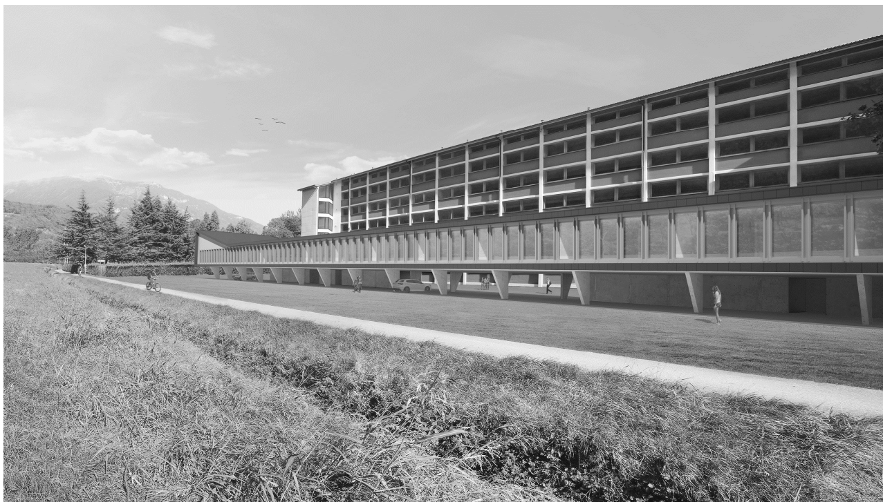
Vista dell'ampliamento dal passaggio ciclo-pedonale.
