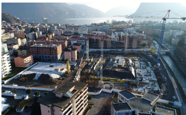
Situazione cantiere gennaio 2018:
