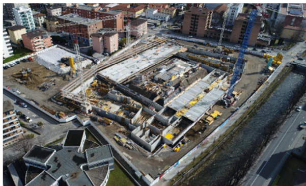
Situazione cantiere marzo 2018
