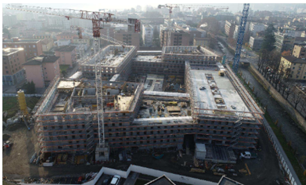
Situazione cantiere dicembre 2018
