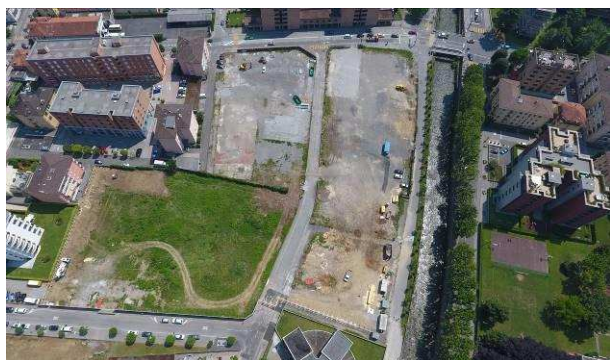
Situazione cantiere marzo 2017:
