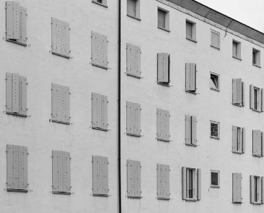
Il lato sud dell'ex filanda Lucchini di Lugano, dopo il restauro del 1992.
