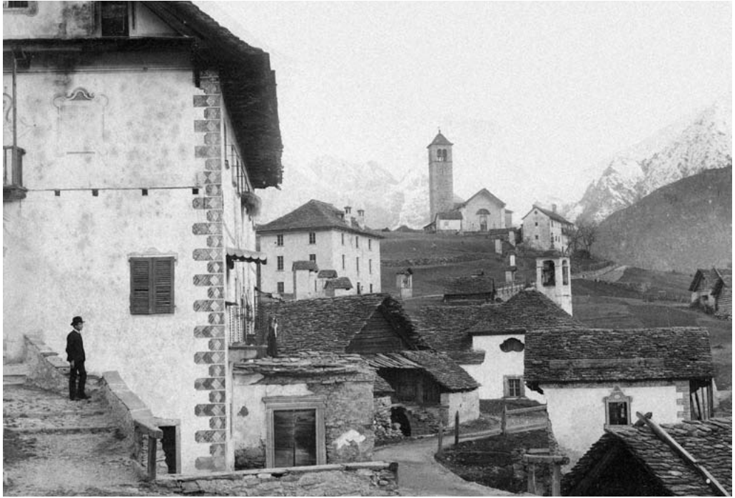
La zona dei Palèzz nel 1895 circa; in primo piano la [Casa ad Fontem]; in basso a destra si intravede il tetto del Fontanóm .
