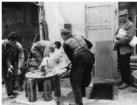
Fig. 109. Poschiavo, quartiere Cimavilla, 1969: il fabbro con i suoi apprendisti durante l'applicazione di un cerchione di ferro alla ruota di un carro (Archivio fotografico Valposchiavo - iSTORIA).
