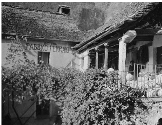
Fig. 110. Avegno, 1916-1917: l'insegna «A. Stoira - Fabbro Ferrario» dipinta sulla facciata di un'abitazione contigua a un'officina (ASTi, Fondo fotografico Ernesto e Max Büchi; fot. E. e M. Büchi).
