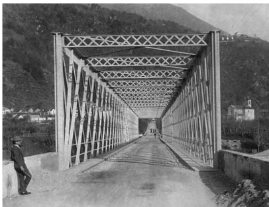
Fig. 96. Losone, 1895 ca.: ponte in ferro sul fiume Maggia con la chiesa di Solduno sullo sfondo (ASTi, Fondo fotografico Famiglia Gianella; fot. A. Monotti).
