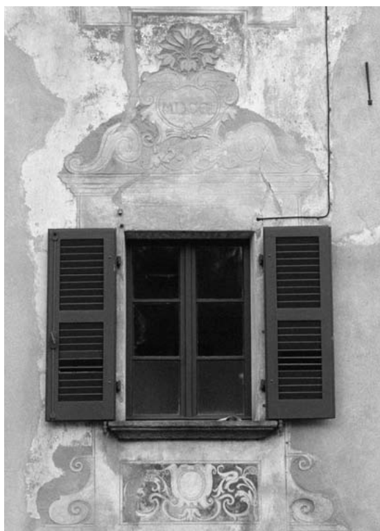
Fig. 86. Riquadratura di finestra in finta architettura su una casa di Minusio; la decorazione risale al 1912 (Arch. CDE; cfr. IDPT 3.139).
