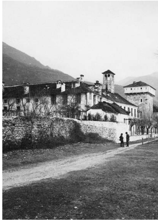
Fig. 97. La Cá da fèr di Minusio in una riproduzione della prima metà del Novecento (Arch. CDE; fot. non identificato; particolare).
