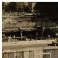
Lavori in Largo Cairoli, l'imbocco della galleria, Settembre 1959, foto: Giancolombo News Photos
