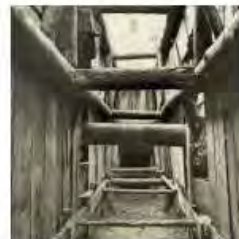
Trincea e galleria trasversale per la deviazione della fognatura, Novembre 1961, foto: G. Chiolini
