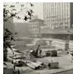
Stazione Cadorna, Scavo generale di sbancamento, Novembre 1959, foto: Publifoto
