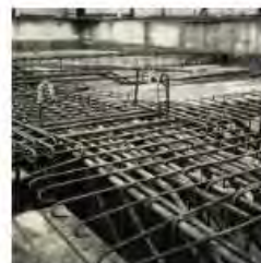
Stazione Cadorna, Particolare dell'armatura metallica della soletta di copertura, Gennaio 1960
