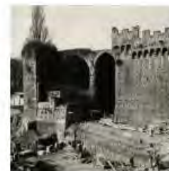
Piazza Castello, Lavori in corso presso il rivellino, Marzo 1961, foto: Publifoto
