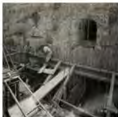
Piazza Castello, Cantiere Fondiaria: getto delle travi speciali sotto pianta nei pressi del Rivellino, Settembre 1961
