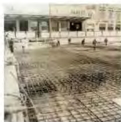
Stazione Cadorna, Armatura metallica della soletta di copertura, Gennaio 1960
