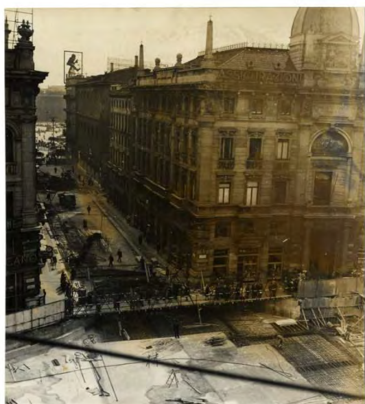
Maggio 1961 - 7° Lotte - Passerella pedonale sovrappassante al collo della stazione Forduato.
