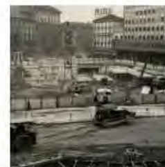
Stazione Cadorna, Lavori in corso in Piazza Cadorna, Gennaio 1960, foto: Publifoto
