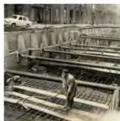
Getto della copertura della galleria, Marzo 1960
