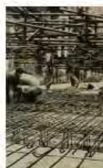
Via Dante, Getto di cemento della galleria, Novembre 1961, foto: Giancolombo News Photos
