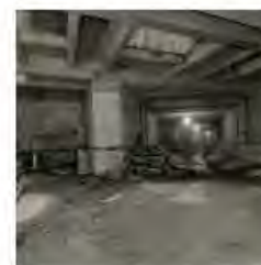
Castello Sforzesco / Via Minghetti, Cantiere S.Spirito, Manufatto d'incrocio della linea 1 con la linea 2 sotto il Castello, Novembre 1961, foto: Publifoto
