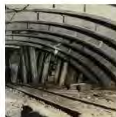
Castello Sforzesco, Linea 2, Armatura della calotta della galleria sotto il Castello, Ottobre 1959, foto: Giancolombo News Photos
