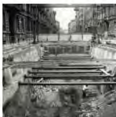
Scavo in trincea per le paratie
