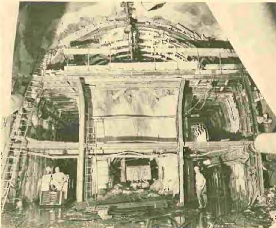
Dallo spaccato al km 5 da Airolo, nella zona del primo attacco intermedio, ci si può rendere conto del sistema di scavo: è il cosiddetto «metodo tedesco», che prevede prima l'attacco degli strozz laterali, poi quello della calotta, poi infine quello dello strozzo centrale.
