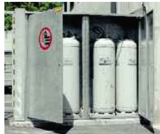
Gas liquefatto stoccato all'aperto – non accessibile alle persone non autorizzate (a prova di vandali!).
