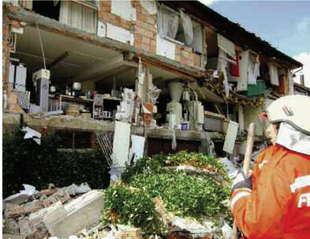
Effetti di un'esplosione di gas.
