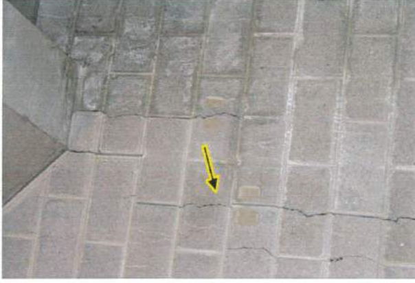
Foto 1: UBICAZIONE : interno palestra muri di tamponamento DIFETTO : lessura ampia
