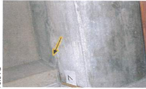
Foto 7: UBICAZIONE: soffitto sopra camminamento gradinate DIFETTO: fessura
