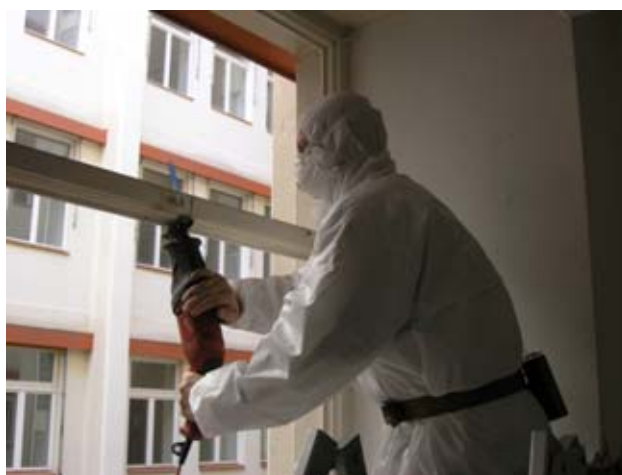
1 Taglio del telaio della finestra con una sega a gattuccio
