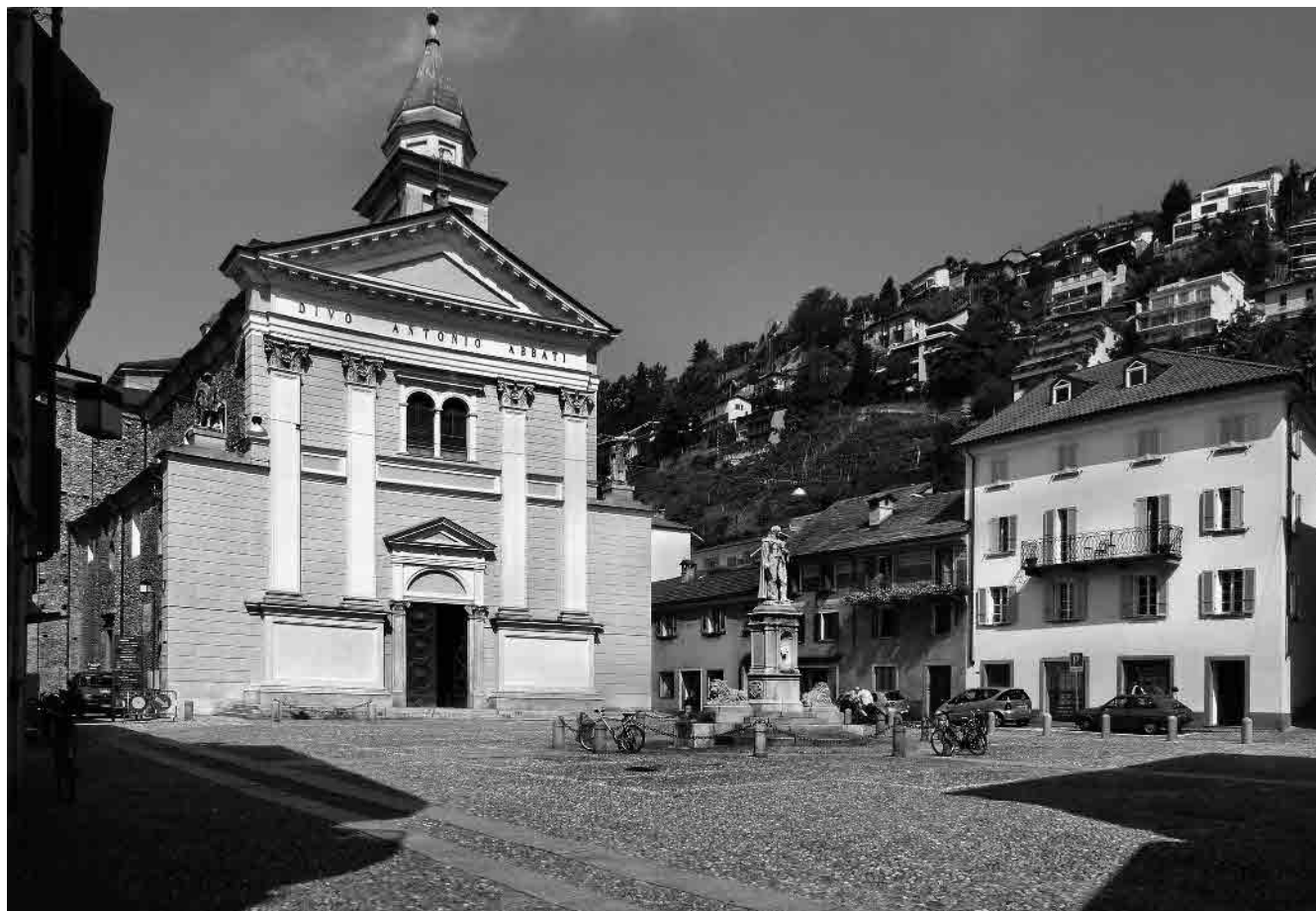
19 La facciata di S. Antonio Abate, ricostruita nel 1873, e monumento a G. Marcacci
