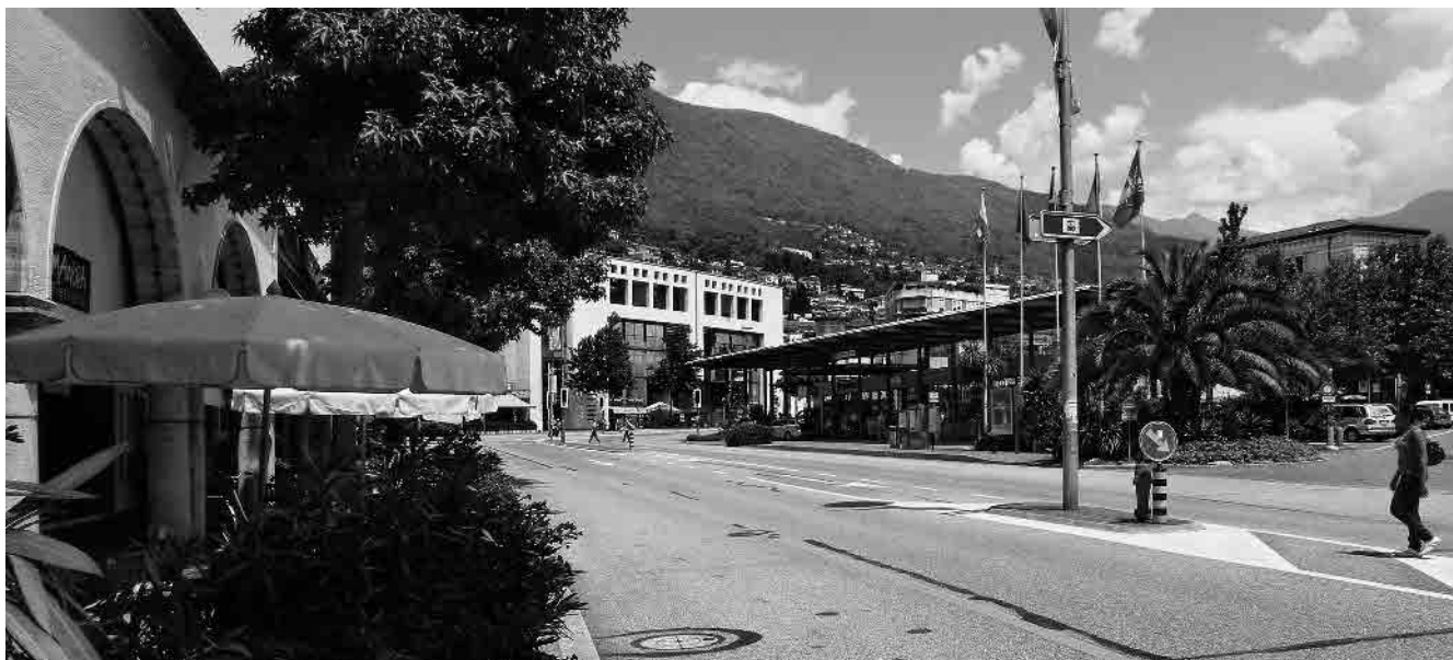
58 Pensilina sul lato ovest della stazione ferroviaria
