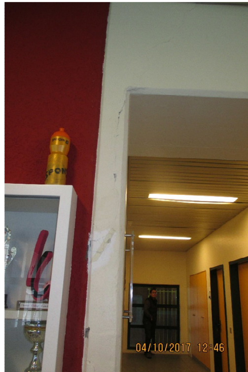
Foto 5 e 6 – Stacchi dell'intonaco delle pareti (rigonfiamenti) nella zona dello scuretto al PT
