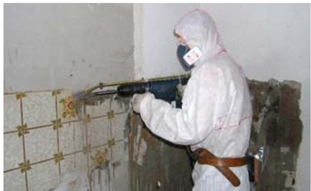
1 Le piastrelle con colla contenente amianto devono essere rimosse a umido con un martello demolitore dotato di nebulizzatore.
