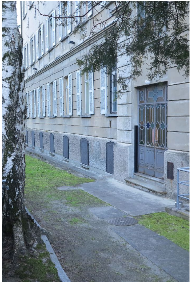
Fossa lato est
