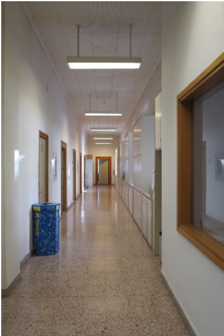
Corridoio lato est
