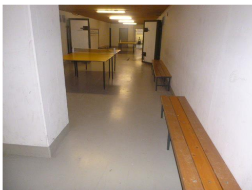
Blocco 2 – Piano Cantina Pavimento in cemento verniciato
