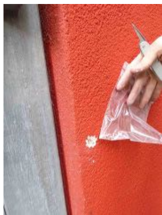
Intero edificio - Materiale 23: intonaco esterno - non contiene amianto
