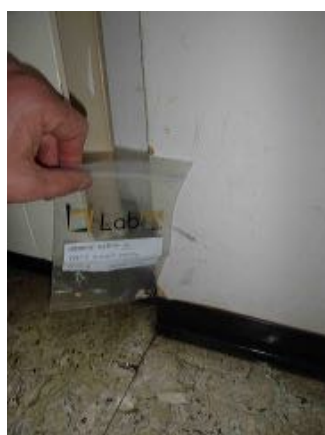
Aula 30 (PC) - Materiale 31: pareti fonoassorbenti - non contiene amianto
