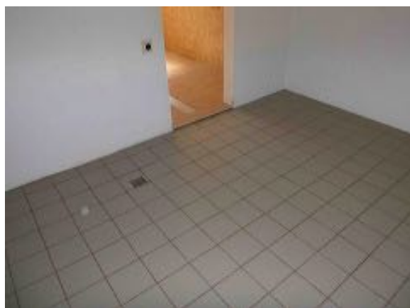
Spogliatoio M e F - Materiale 7: colla sotto piastrelle pavimento - non contiene amianto
