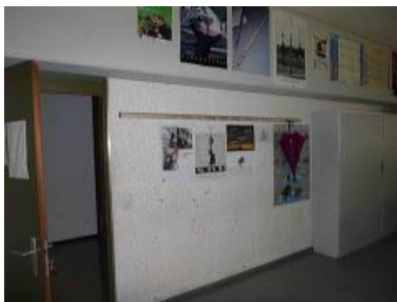
Aula musica - Materiale 26: pannelli fonoassorbenti forati - non contiene amianto
