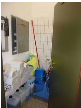
Ripostiglio pulizie - Materiale 3: colla sotto piastrelle pavimento - non contiene amianto; Materiale 4: colla dietro piastrelle pareti - contiene amianto
