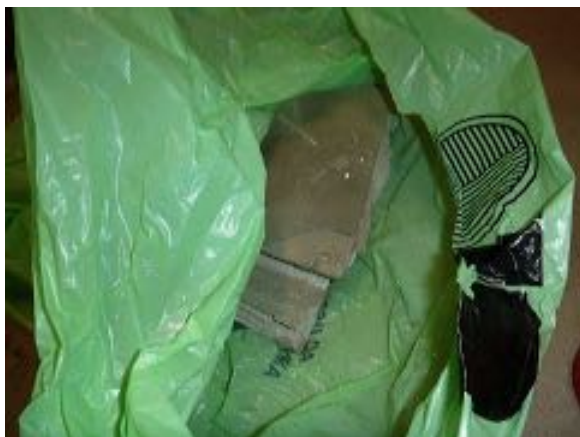
PC magazzino - Materiale 34: cartoncino sotto le lampade - contiene amianto
