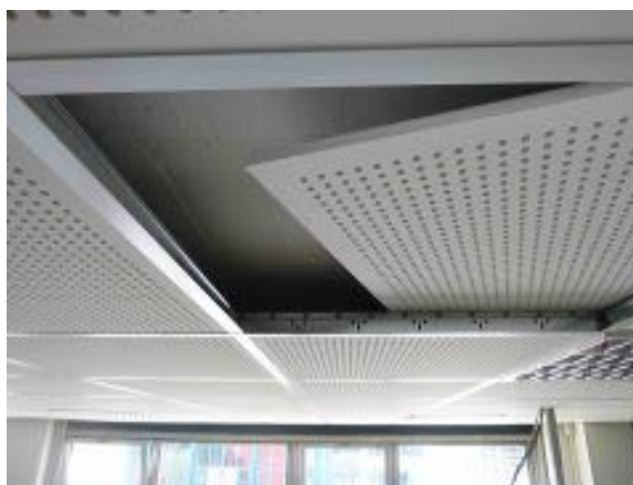
Controsoffito forato nuovo (2004)
