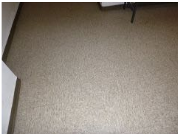
Spogliatoio M - materiale 29: novilon pavimento - non contiene amianto
