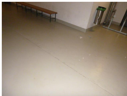
Blocco 2 – Piano Cantina Pavimento in cemento verniciato
