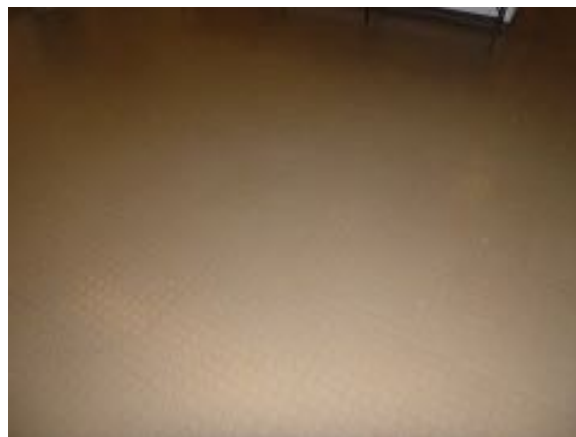
Spogliatoio F - materiale 30: rivestimento pavimento - non contiene amianto
