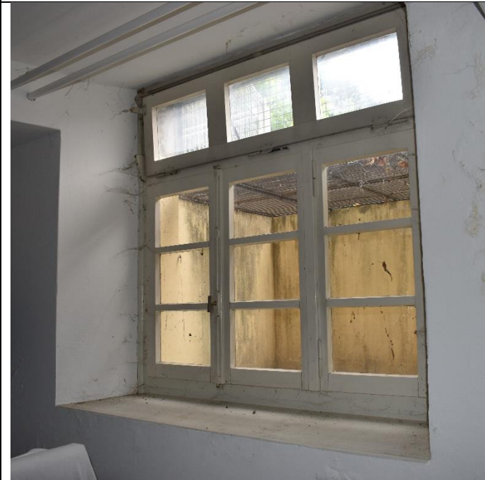
Finestre in legno in cantina (futura tipo D)
