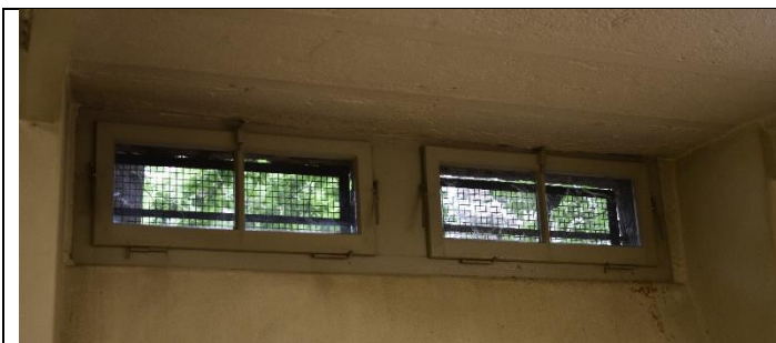
Finestre in cantina (Tipo M)
