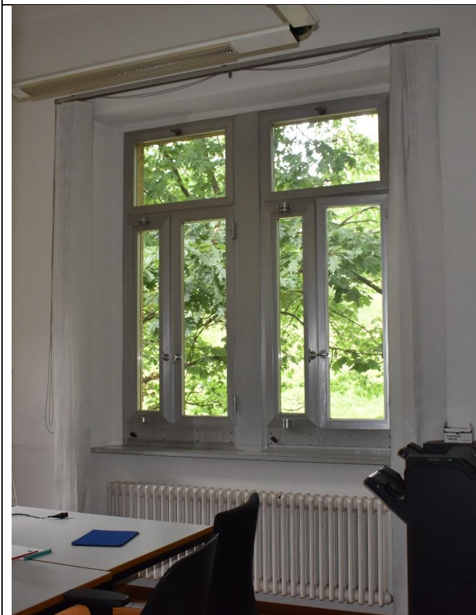
Finestra dall'interno (futura tipo C)
