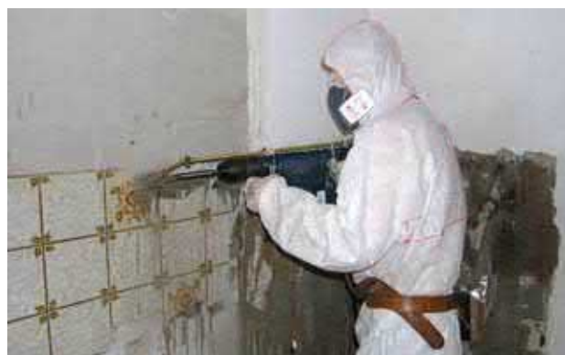
1 Le piastrelle con colla contenente amianto devono essere rimosse a umido con un martello demolitore dotato di nebulizzatore.
