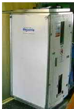
2 Accesso alla zona da bonificare (unità di decontaminazione, a tenuta stagna)
