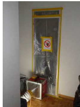
5 Zona da bonificare confinata con estrattore d'aria
