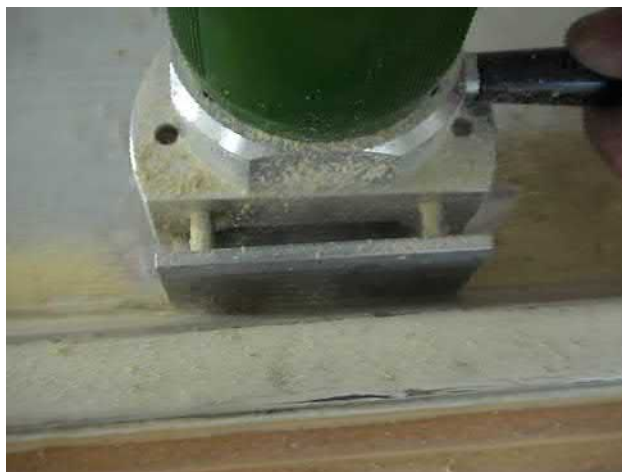
1 Rimozione dello stucco per finestre con una sega tagliagiunti
