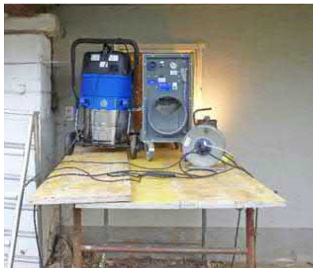
3 Apparecchio di ventilazione integrato in una finestra e sigillato ermeticamente. Il tubo flessibile dell'aspiratore passa attraverso la parte sigillata.
