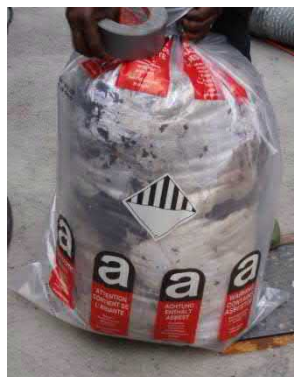
2 I rifiuti devono essere imballati in sacchi di plastica antirottura a chiusura ermetica.
