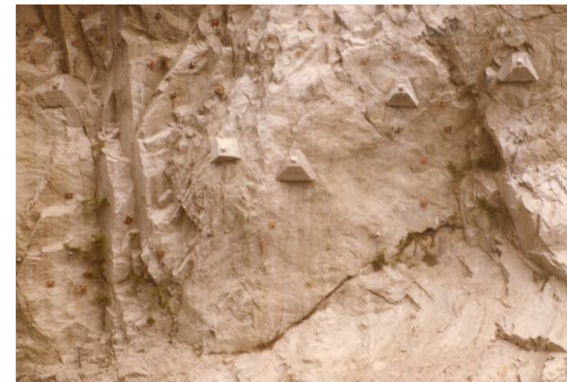
Vista parete assicurata / dettaglio
