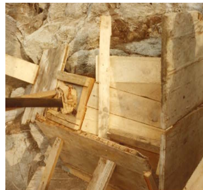
Dettaglio cassero per prismi in calcestruzzo
