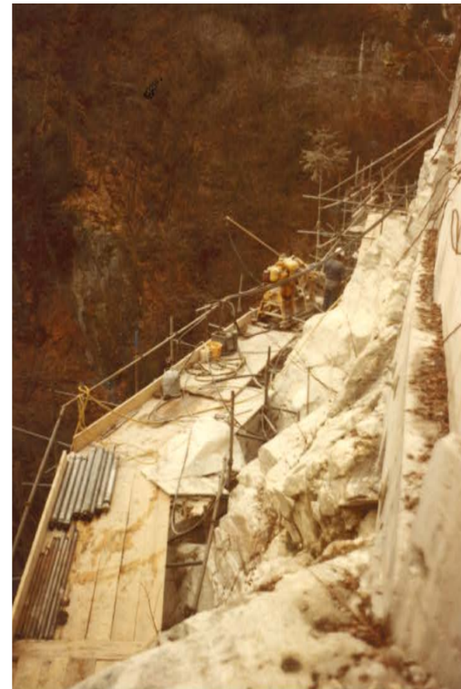
Dettaglio cassero per prismi in calcestruzzo
