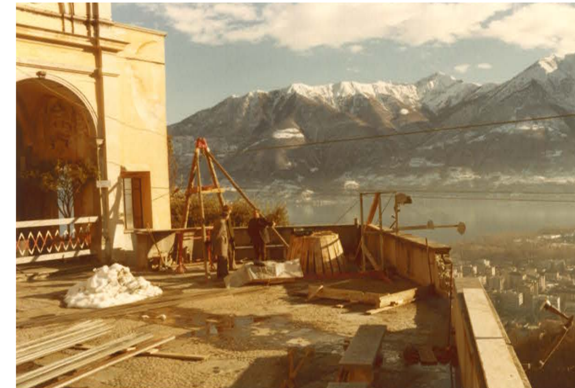
Sagrato / Area di cantiere - mezzi di sollevamento
