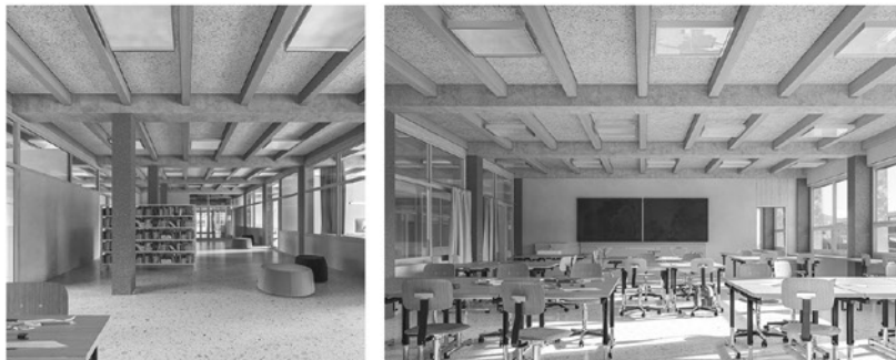
Principio costruttivo: 1. costruzione in CA riciclato (continuità strutturale / antisismica) 2. accoppi verticali in gres / granito locale 3. architravi prefab. in CA (struttura primaria) 4. travi in legno (struttura secondaria) 5. pannelli multistrato legati alla struttura 6. elementi di facciata prefab. con semmenti e protezione solare 7. stratificazione pavimenti (travi / anticappello / grangia)
