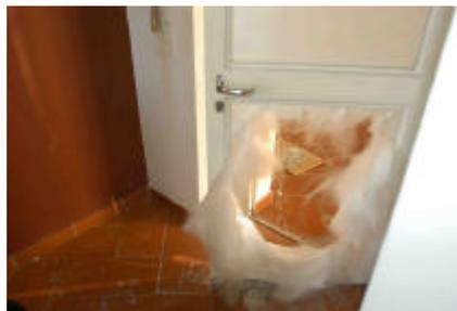
*Per una buona prevenzione contro i furti, porte e telai devono costituire un corpo unico, realizzati con materiali resistenti. Il cilindro non deve sporgere dalla serratura. Il chiavistello deve consentire almeno due mandate, e penetrare per un minimo di 20 mm.*
