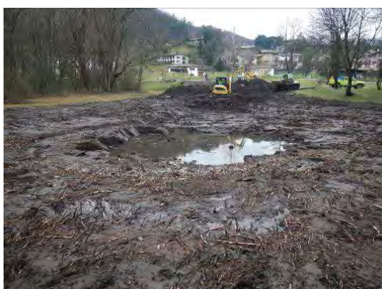
Figura 1: la superficie durante i lavori
