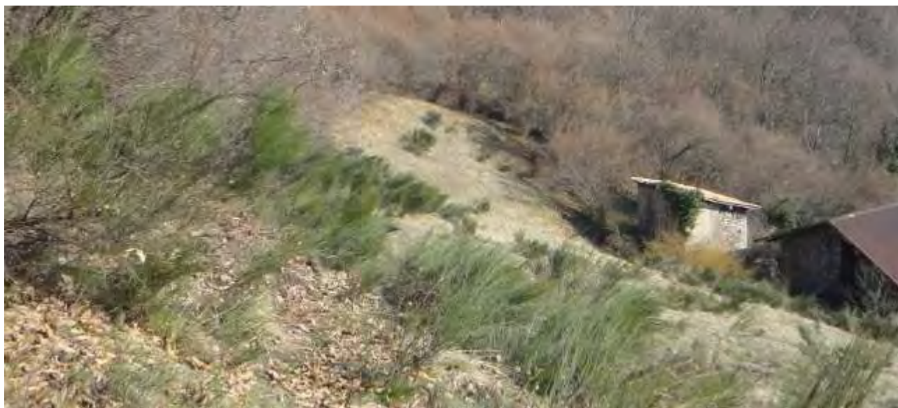
Figura 11: superficie prima degli interventi
