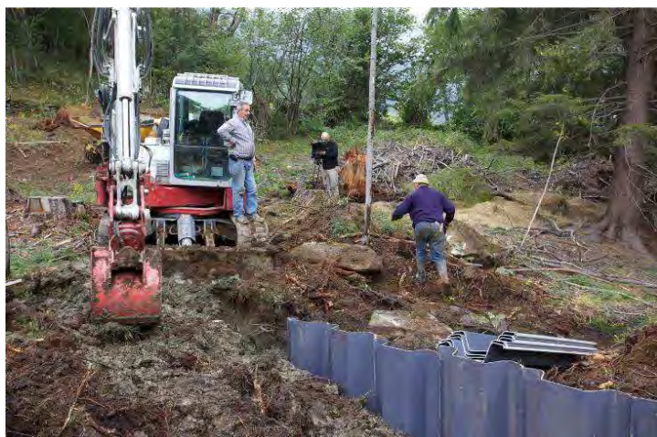
Figura 68: posa delle palancole
