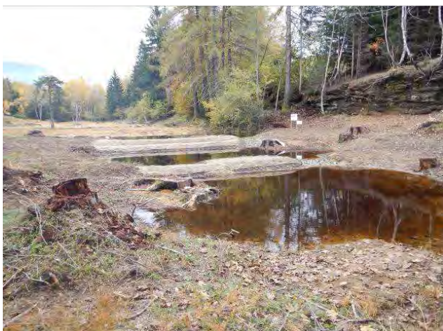
Figura 69: situazione barriere a lavori ultimati
