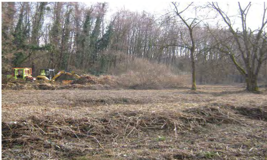
Figura 78: durante i lavori
