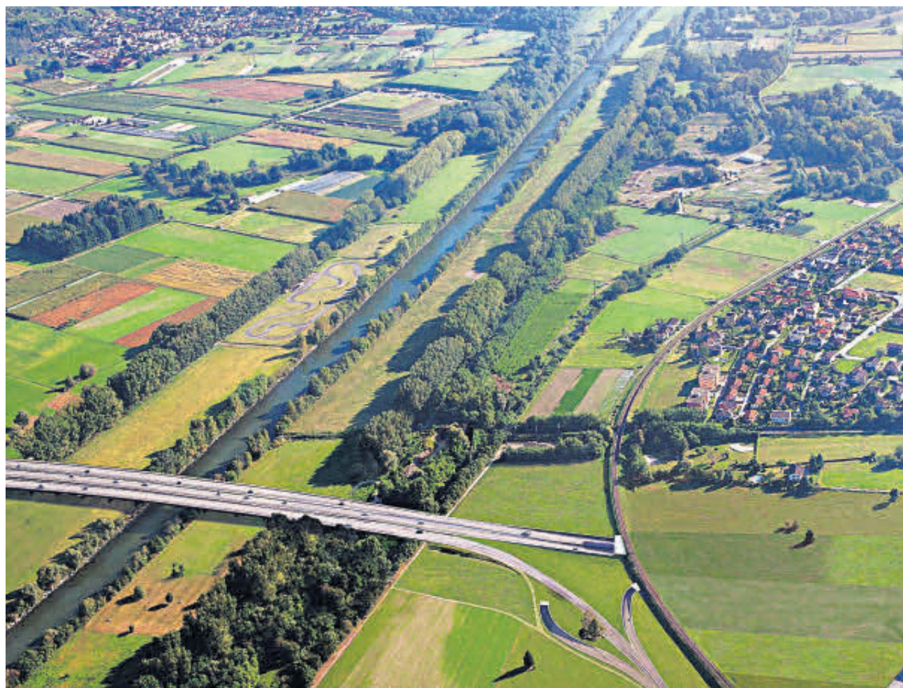
VICINE L'attuale strada cantonale sarà spostata, affiancando il nuovo viadotto dell'A2-13 sul Ticino, in modo che vi sia un solo attraversamento del Piano di Magadino. (Foto Dipartimento del Territorio)
