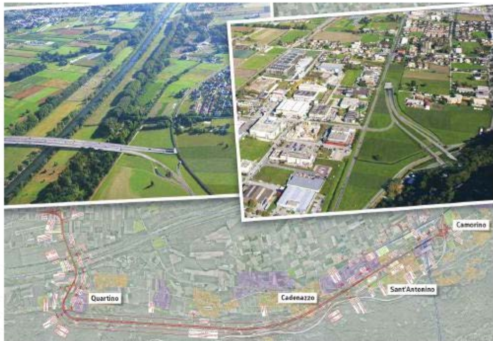
Sopra: il sommovincolo di Quartino (con galleria artificiale) e quello di Sant'Antonino. Sotto, il tracciato, in gran parte in galleria
