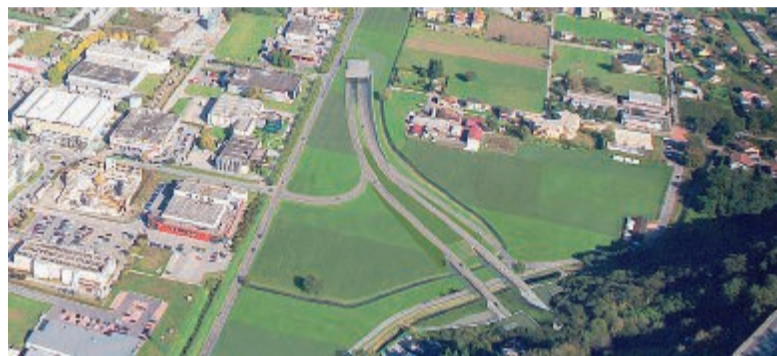
Nei fotomontaggi forniti dal CdS, in alto il ponte sul Ticino e il semisvincolo di Quartino. Sotto, l'uscita nord della galleria, il semisvincolo e il tunnel sotto il Piano.
