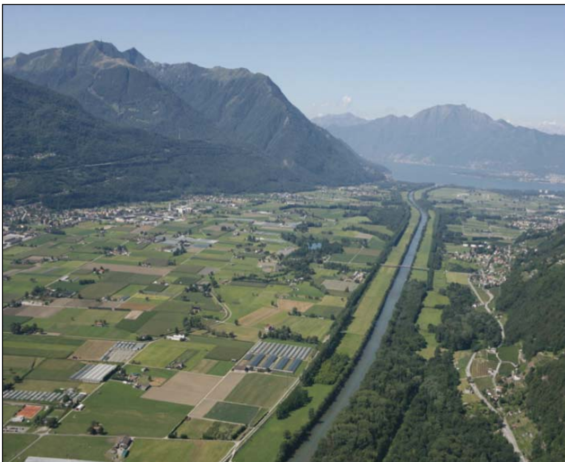
Figura 9: Vista aerea del Piano di Magadino
