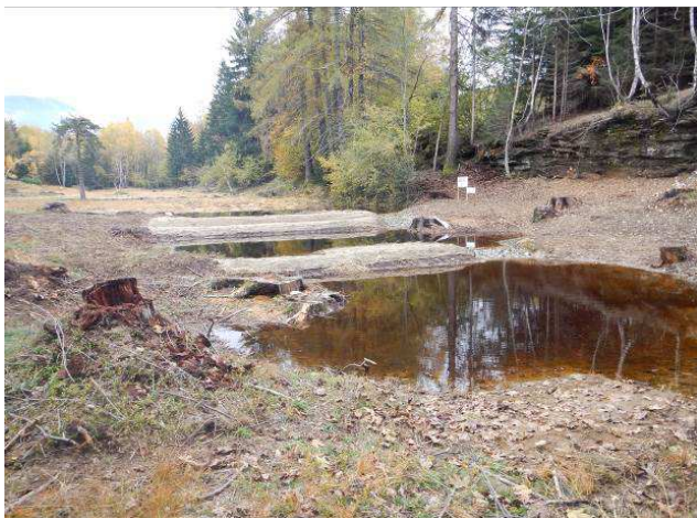
Figura 69: situazione barriere a lavori ultimati
