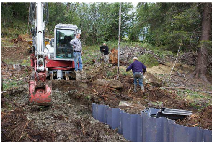
Figura 68: posa delle palancole
