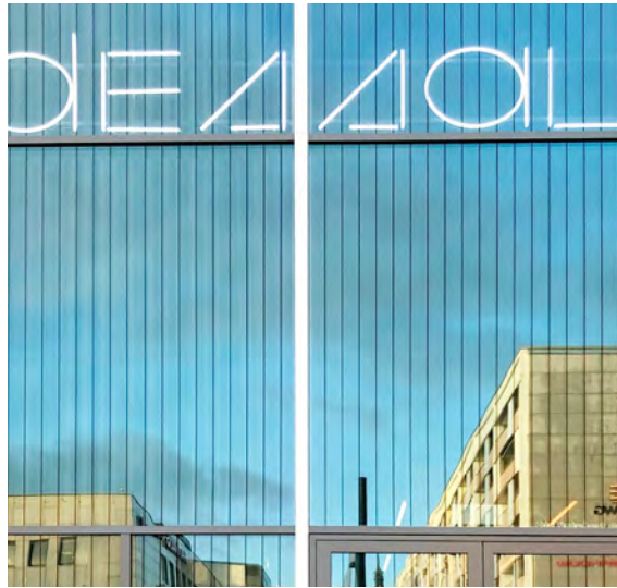
Per una protezione da collisioni di uccelli, nel nuovo Museo Bauhaus di Dessau (Germania) più di 2700m 2 di facciate in vetro sono stati dotati in un secondo tempo di un motivo a linee prestampato.
