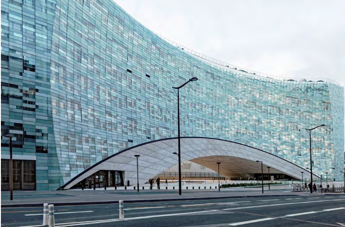
La facciata della sede centrale di Le Monde, realizzata da Snøhetta a Parigi, è composta da oltre 20 000 elementi in vetro. Variano per struttura e trasparenza e sono disposti in modo da massimizzare la luce negli uffici e la vista verso l'esterno nelle giuste posizioni.
