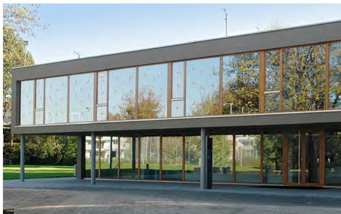
A causa dei forti riflessi della vegetazione, sulle grandi vetrare della Scuola cantonale di Beromünster (Svizzera) si verificavano frequenti collisioni di uccelli. Per questo circa 20 anni fa erano state applicate sagome di rapaci, che tuttavia non hanno permesso di migliorare in alcun modo la situazione. Con un progetto scolastico, i bambini hanno allora progettato una creativa marcatura delle finestre che soddisfasse i requisiti per un'efficace protezione degli uccelli.
