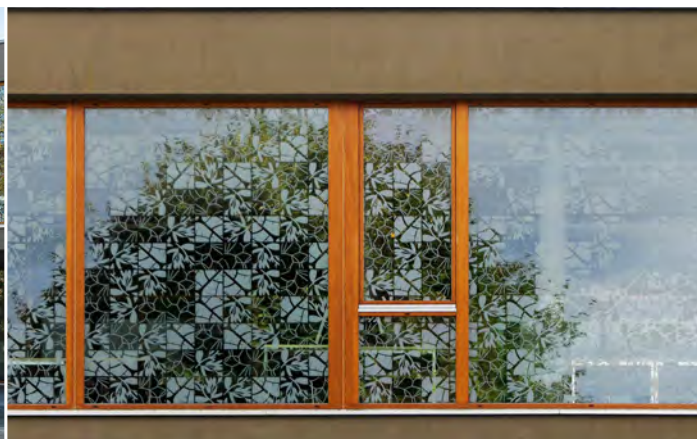
A causa dei forti riflessi della vegetazione, sulle grandi vetrare della Scuola cantonale di Beromünster (Svizzera) si verificavano frequenti collisioni di uccelli. Per questo circa 20 anni fa erano state applicate sagome di rapaci, che tuttavia non hanno permesso di migliorare in alcun modo la situazione. Con un progetto scolastico, i bambini hanno allora progettato una creativa marcatura delle finestre che soddisfasse i requisiti per un'efficace protezione degli uccelli.
