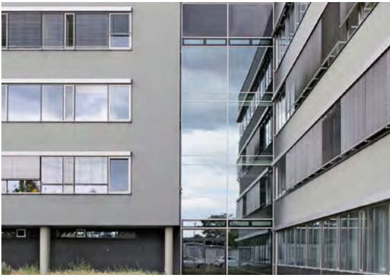
Lunghe fasce di finestre e vetrate riflettenti sono percepite dagli uccelli come un comodo passaggio per volare attraverso la struttura dell'edificio. Le singole suddivisioni delle superfici vetrate hanno scarsa influenza sulla riduzione delle collisioni.
