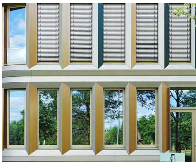
Se abbassate, le gelosie esterne possono proteggere da collisioni. Non sono tuttavia adatte come soluzione permanente, poiché sono una misura che dipende dall'utente.
