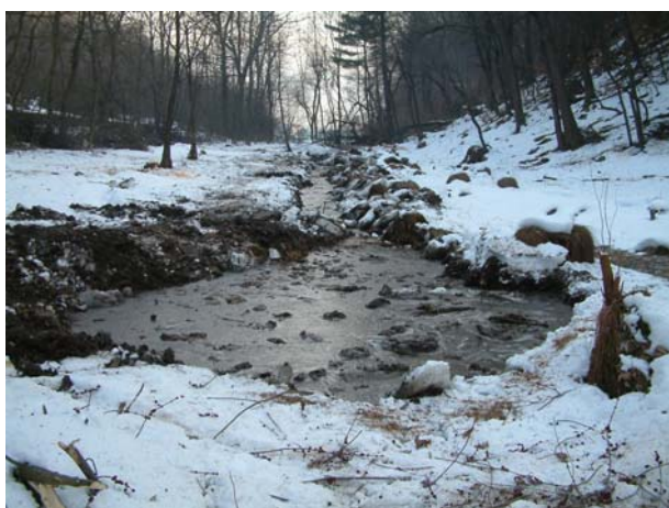
Figura 9. Situazione al termine degli interventi di scavo dello stagno e del canale (febbraio 2006).
