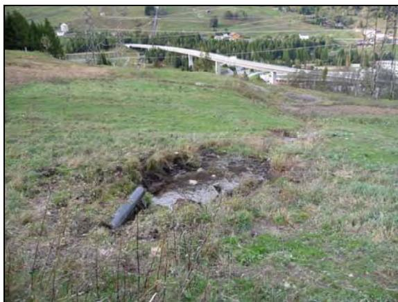
Figura 2: Tubazione di sfogo con formazione di deflusso superficiale e problemi di erosione
