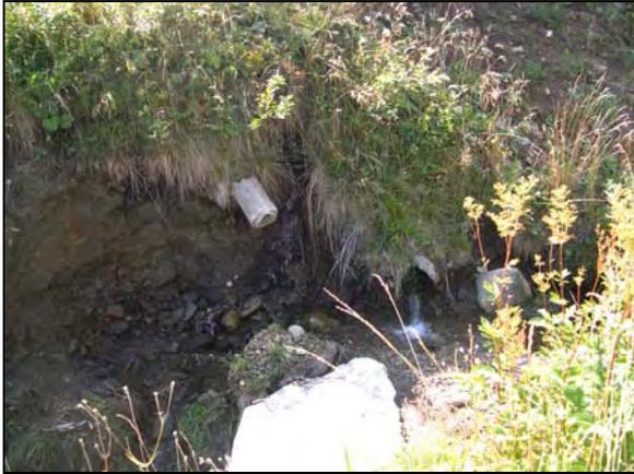
Figura 3: Cunetta di drenaggio, con danni da erosione
