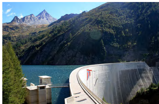
Fig. 21: Diga del Luzzone (Foto: Ivan Sasu)
