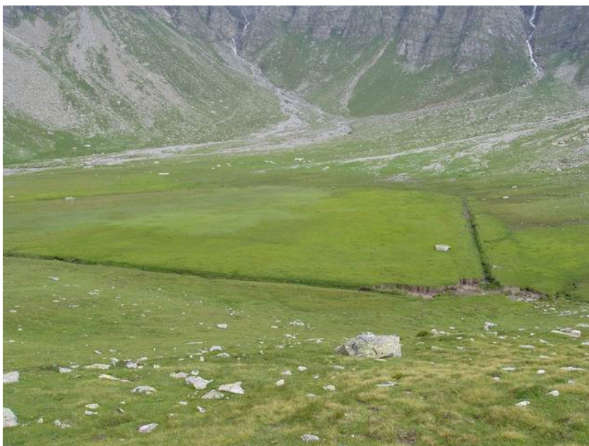
Figura 33: drenaggi esistenti prima degli interventi
