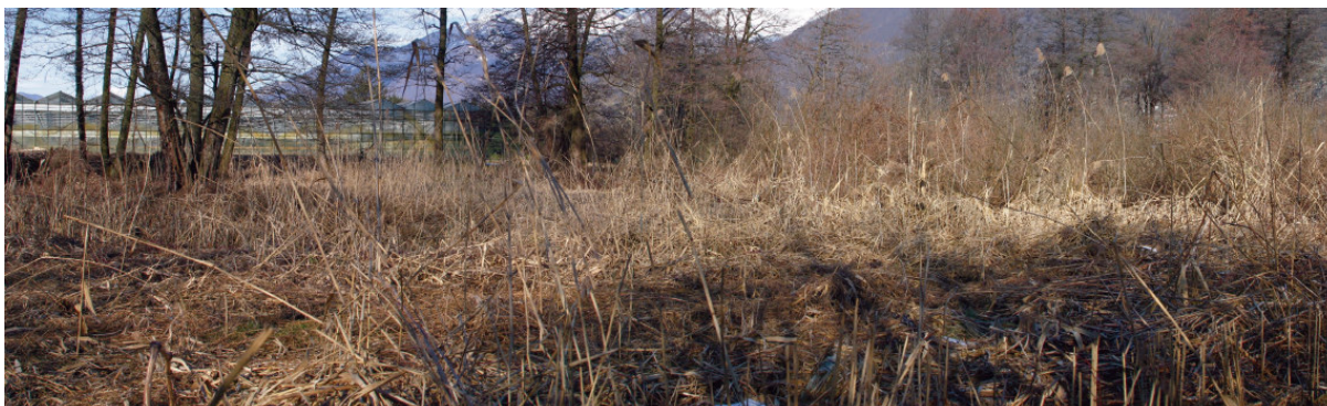
Figura 35: il settore ovest prima degli interventi di manutenzione
