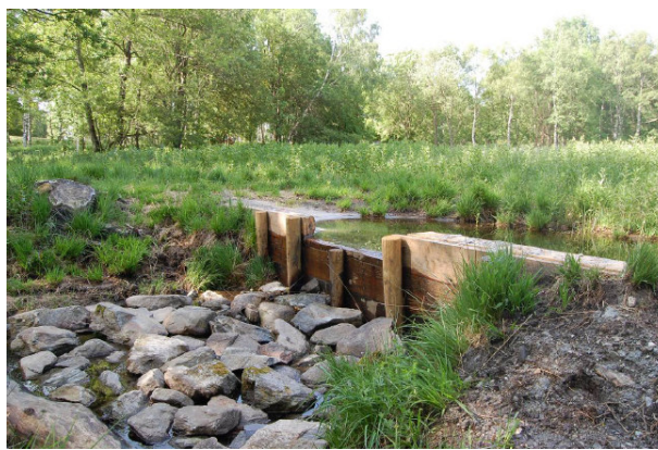
Figura 32: esecuzione di una briglia (sinistra) e situazione al termine dei lavori (destra)
