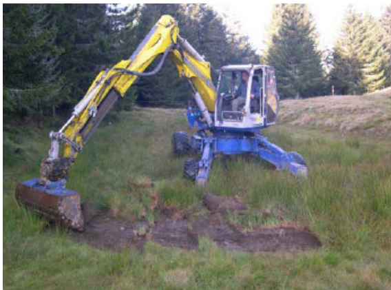
Figura 29: operazioni di sterro (sinistra), biotopo ripristinato con pali tutori e primo ristagno di acqua (destra)
