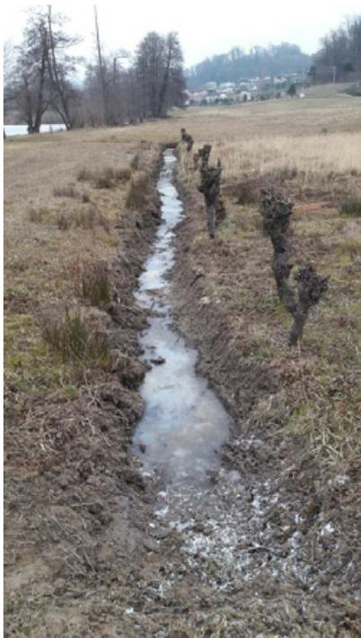
Riprofilatura e spurgo di un canale presso una superficie a strame.
