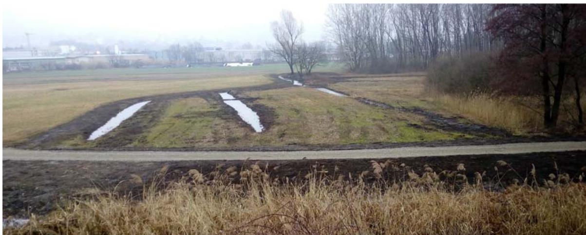
Sistema di canali di drenaggio ripuliti e dotati di briglie in legname
