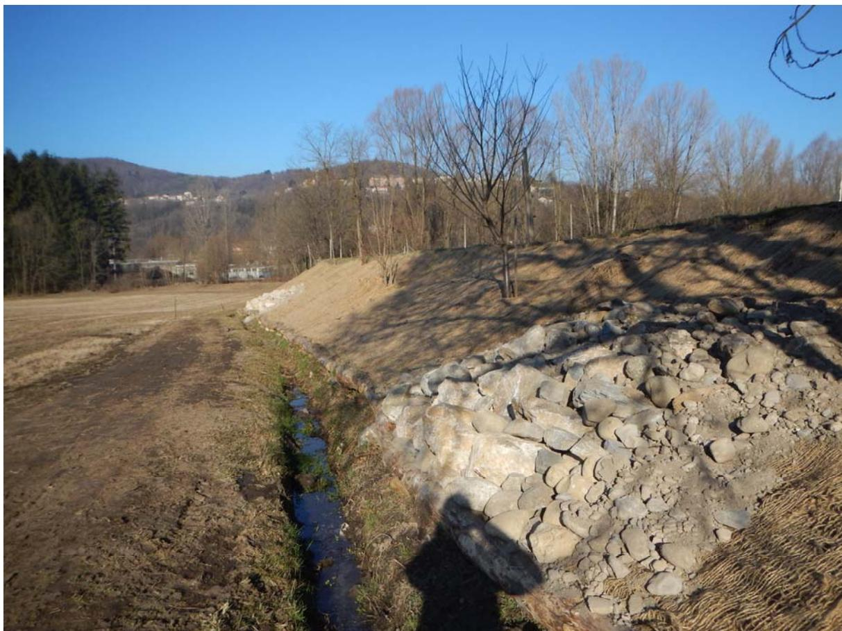
Dettaglio strutture per piccola fauna e scarpata pronta per piantagione nuova siepe
