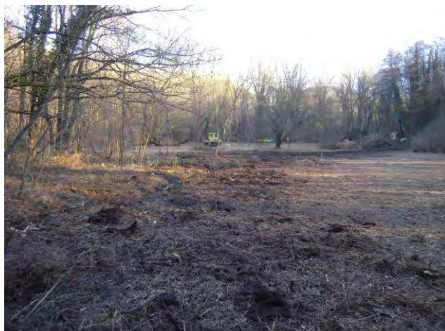
Figura 8 – Interventi di riapertura superficie palustre
