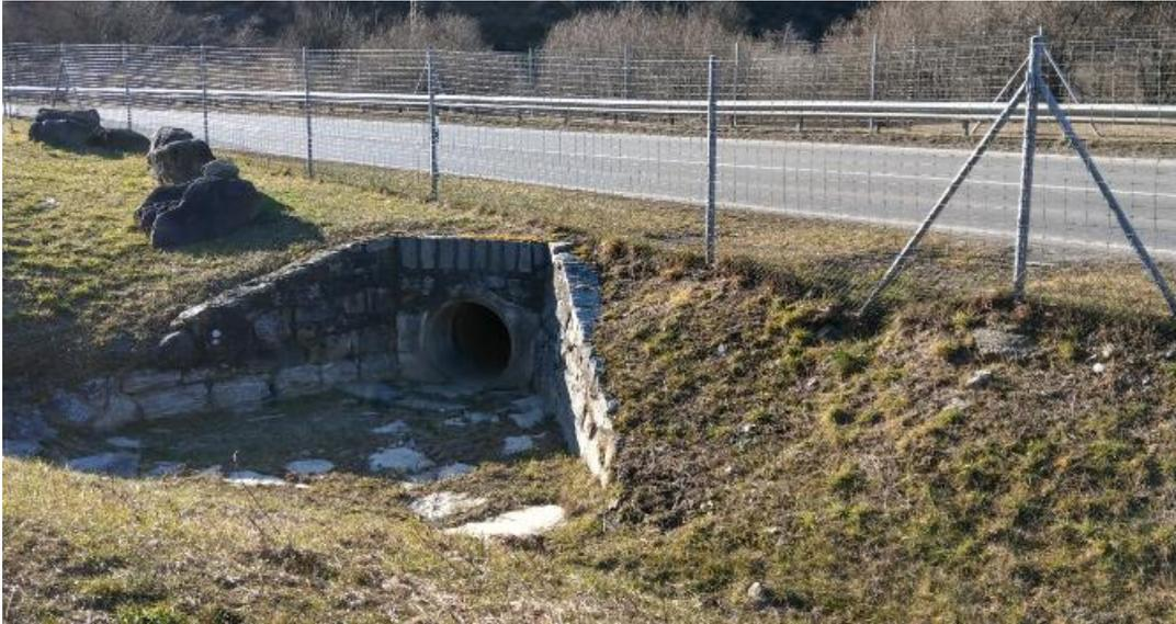
Figura 22 Vista del tombino per il sottopassaggio della strada cantonale
