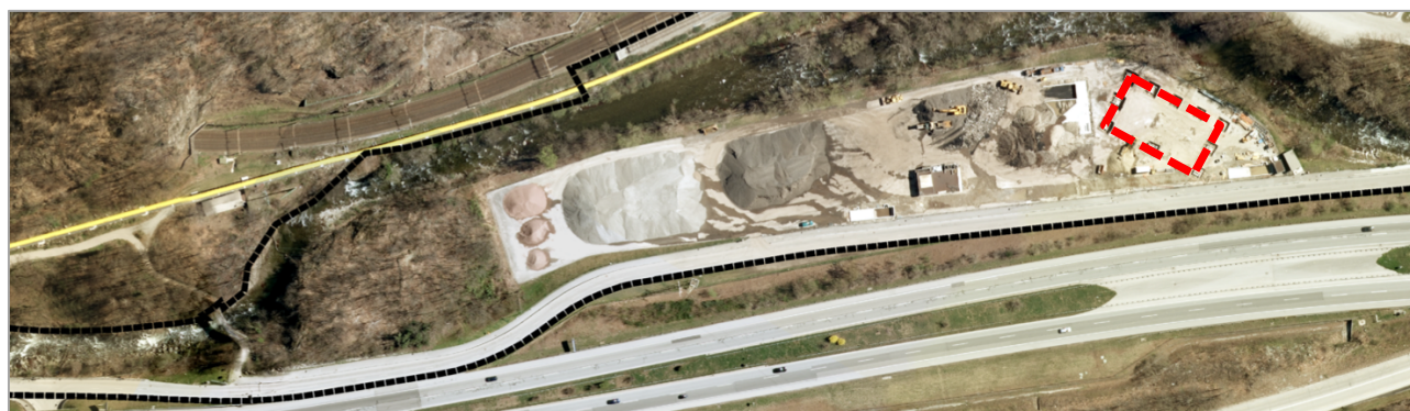
Figura 6 – Strutture presenti nel settore 2 (raccordo ferroviario: polo lavorazione e produzione miscele bituminose) allo stato attuale, in sponda destra del fiume Vedeggio.
