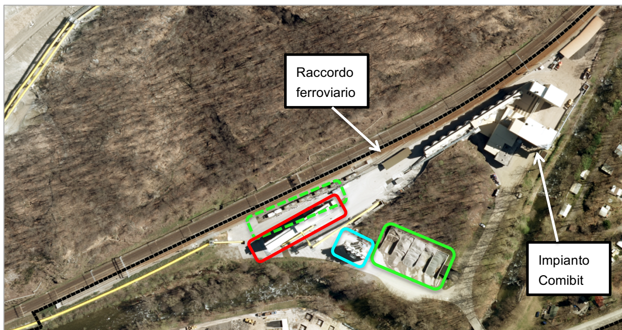
Figura 5 – Strutture presenti nel settore 2 (raccordo ferroviario: polo lavorazione e produzione miscele bituminose) allo stato attuale, in sponda sinistra del fiume Vedeggio. In verde (linea continua) sono evidenziati i setti spostati nell'ambito del progetto ATG, la linea verde tratteggiata indica approssimativamente la posizione originale dei setti. In blu sono evidenziati i silo per il cemento, in rosso i silo per inerti, entrambi costruiti nell'ambito del progetto ATG.
