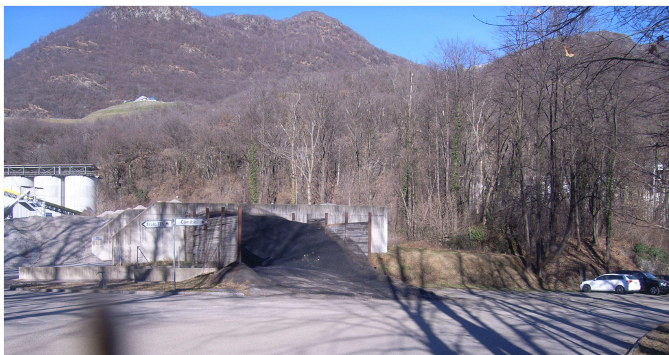
Figura 13: Vista del promontorio boscato della zona industriale in sponda sinistra, dal ponte di accesso alla zona (sulla sinistra setti e sili realizzati per il progetto ATG)
