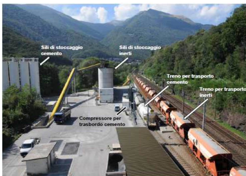
Figura 20: Panoramica dello scalo ferroviario di Sigrino (Fonte: Raccordo ferroviario Sigrino - Centri inerti cantonali, Studio di massima, FFS Sviluppo della rete, 16.12.2016)
