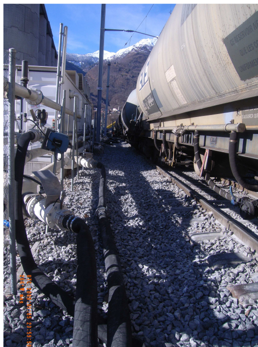
Figura 21: Adattamenti dello scalo ferroviario per lo scarico materiali inerti (in alto tramoggia) e cemento sfuso (a destra pompaggio)
