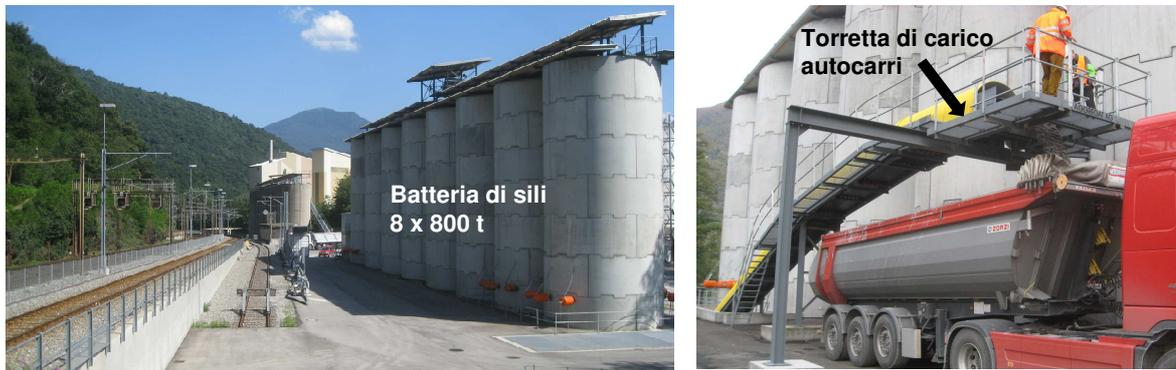
**Figura 16 – Batteria di sili 8 x 800 t e torretta di carico autocarri**
