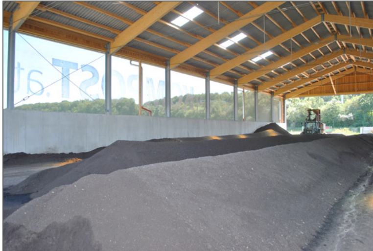
Figura 3.6 – Esempio di un compostaggio in capannone aperto (ARGE Kompost Enns, Austria).
