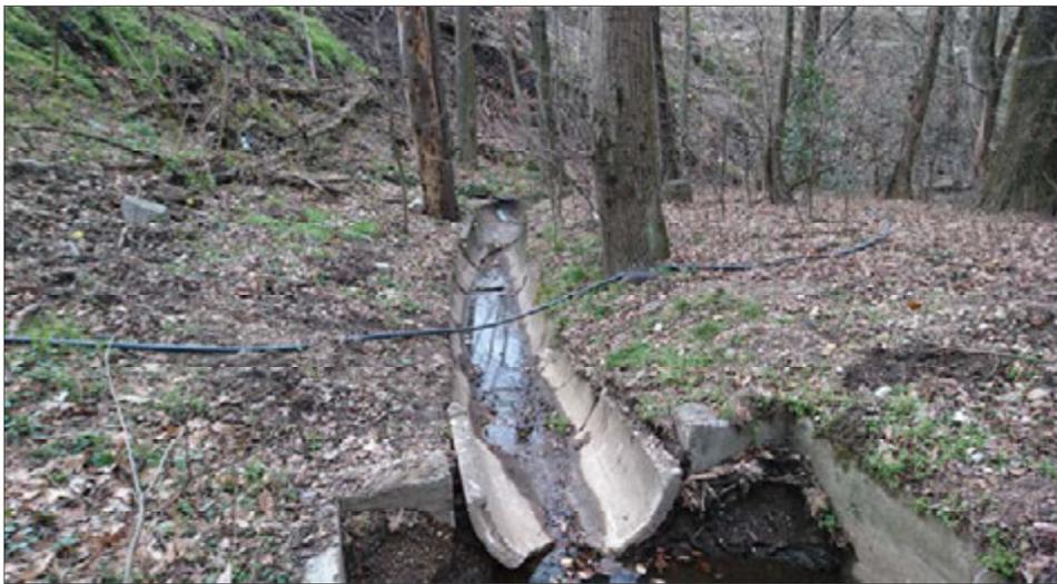
Figura 7.14 - Immagine del torrente San Zeno (stato di fatto al 4 marzo 2016). Il corso d'acqua scorre attualmente all'interno di una struttura in calcestruzzo, completamente artificiale.
