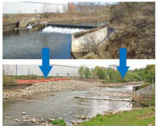
Rimozione traversa o camera di
