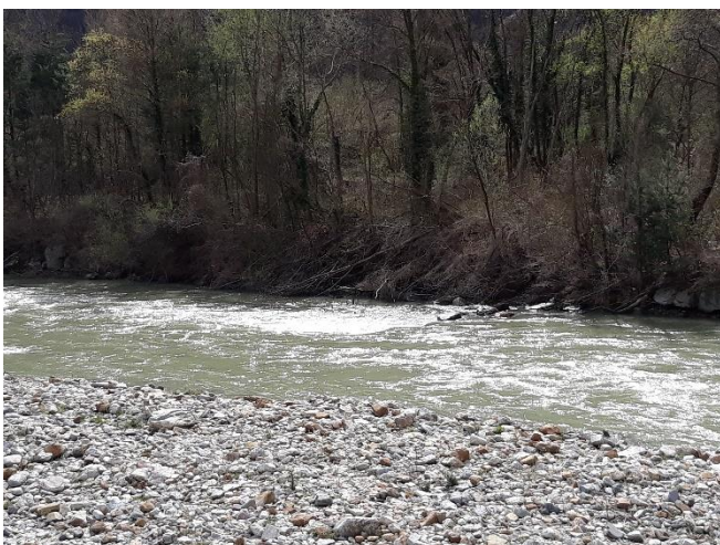
Vista verso valle, con pennello di deviazione della portata verso il centro dell'alveo
