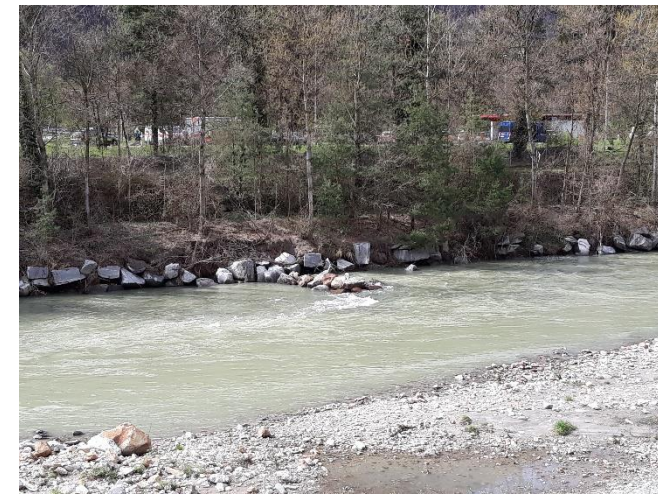
Vista del pennello collocato sulla sponda di fronte al banco di sedimenti, per strutturazione/diversificazione alveo e per favorire l'erosione del banco stesso
