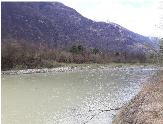
Località al Bosco a Cresciano, presso l'inizio del banco di sedimenti di Cresciano. Vista verso monte dell'alveo del Ticino rettificato e omogeneo
