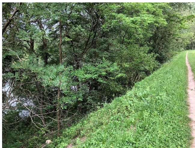
Vista dell'arginatura sulla sponda destra della Moesa che non può essere mitigata o spostata. La stessa, data la larghezza laterale, funge da passaggio faunistico
