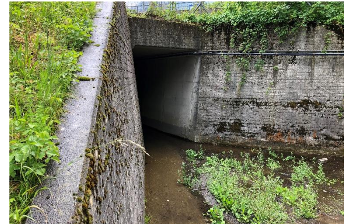
Imbocco del tombinone a monte del tratto autostradale
