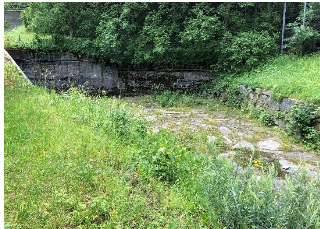
Situazione attuale a monte del tratto autostradale: sponde e fondo lastricato che possono essere rinaturati
