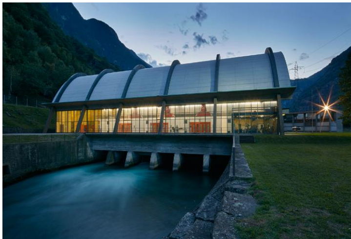
Centrale AET Nuova Biaschina (immagine AET)
