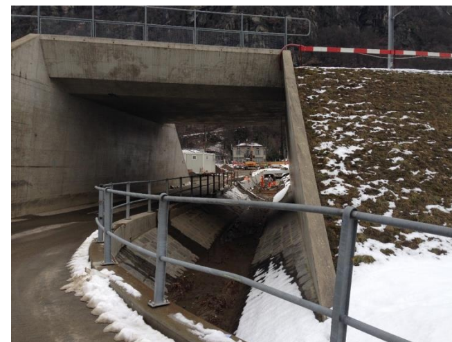
Canale Pedemonte a valle della strada cantonale. In questo punto il corso d'acqua sottopassa la ferrovia e si collega con le zone oggetto di riqualifica AlpTransit (biotopo Raméi) e il Brenno
