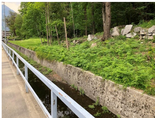
Canale Pedemonte nella parte bassa di via alle Vigne, dove c'è un ottimo potenziale per riconnettere il riale con il versante soprastante incrementandone la funzionalità come passaggio per la fauna
