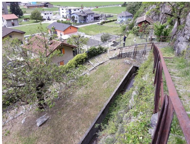
Manufatto in cemento per la raccolta e il drenaggio delle acque di scolo al piede della parete; l'area pubblica verde si trova presso l'inizio del sentiero di interesse storico verso Diganengo, località La Senda
