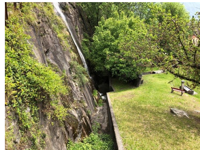
Area verde in località La Senda. I manufatti di raccolta delle acque in beton potrebbero essere riqualificati per permettere una valorizzazione sia dal punto di vista fruitivo che naturalistico dell'area
